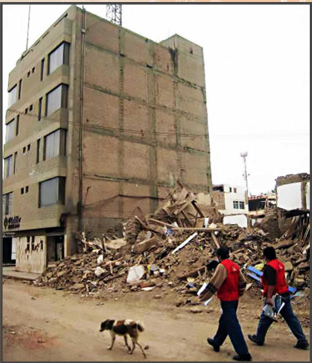
Edificio in muratura confinata rimasto intatto nel terremoto del 2007 a Pisco, in Perù, di Magnitudo 8.0. Accanto altre costruzioni completamente collassate.
